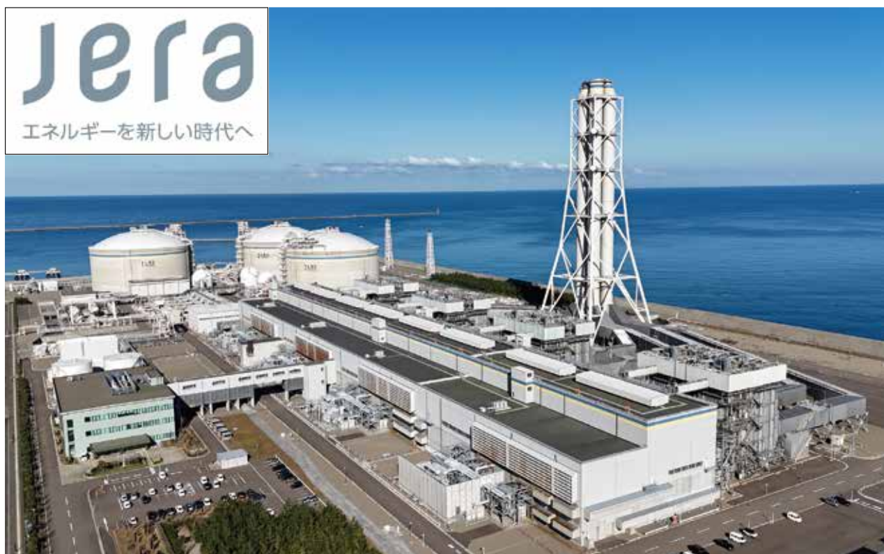
株式会社 JERA 上越火力発電所 上越市八千浦 2
